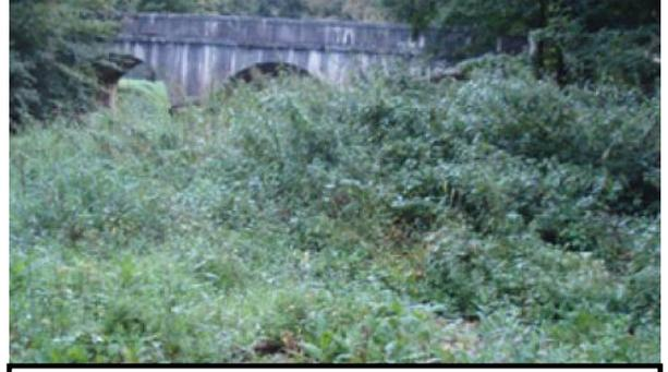
**Photo 6 : Banc de sédimentation en amont du pont qui ne doit faire l'objet d'aucun traitement.**
