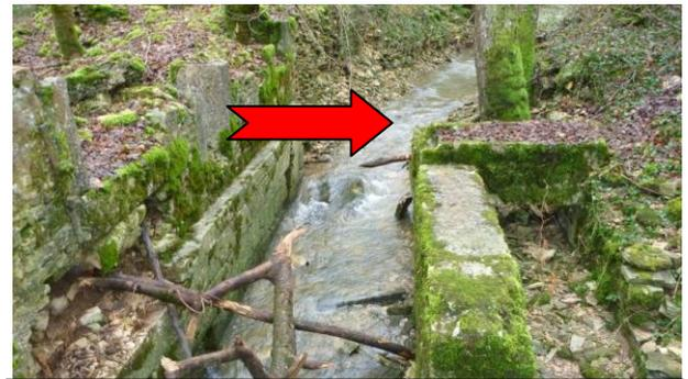
Photo 4 : Reste de muret et embâcle obstruant le chenal d'aménage et devant faire l'objet d'un enlèvement.
